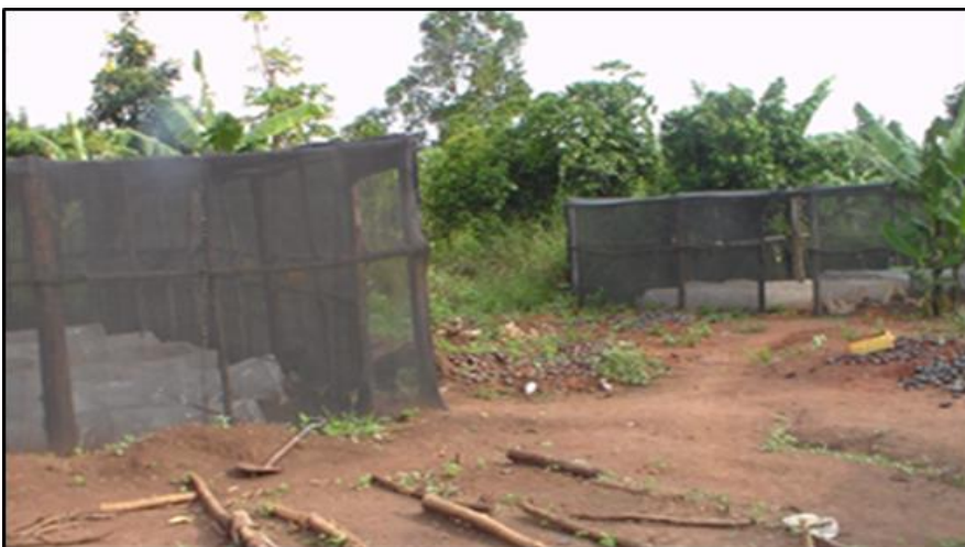
2. Le due serre costruite
